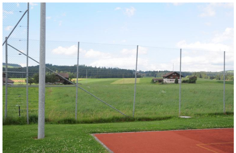
Bild 2 (neues Rasenfeld): Hinter dem Hartplatz erfolgte am 8. Mai der Spatenstich zum neuen Rasenfeld, das als erste Bauetappe des Oberstufenzentrums Unterlangenegg in Angriff genommen wird.
